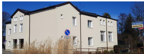
Plac Kaszubski w Rumi. W tym budynku powstanie Biblioteka Kaszubska.
